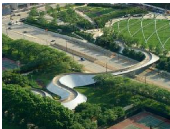
Hình 35. Hình thức công trình cầu vượt hòa nhập với không gian chung
