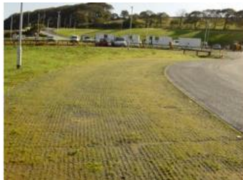
Hình 30. Bãi đỗ xe bằng cỏ kết hợp hệ thống gia cố cỏ (gạch lát cỏ bằng nhựa thấm nước)
