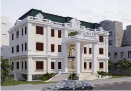
Kiến trúc Cổ điển, mái Mansard
