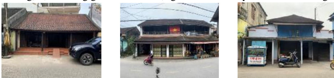
Hình 70. Hình thức kiến trúc nhà truyền thống cần gìn giữ và khuyến khích
