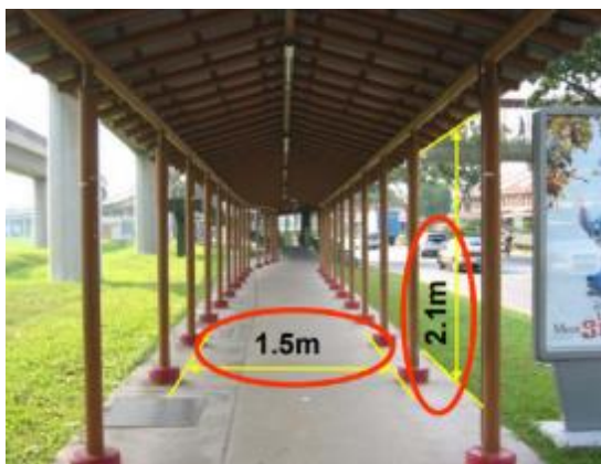
Hình 25. Một số tiêu chuẩn kích thước cơ bản trong thiết kế lối đi có mái che
